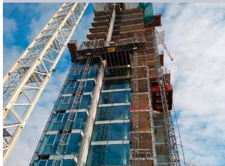
Die Mastkletterbühnen verfügen über spezielle Teleskop-Ausfahrvorrichtungen
