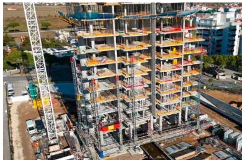
Safi-Geräte im Einsatz am Richard-Meier-Tower im Jesolo Lido Design District ...
