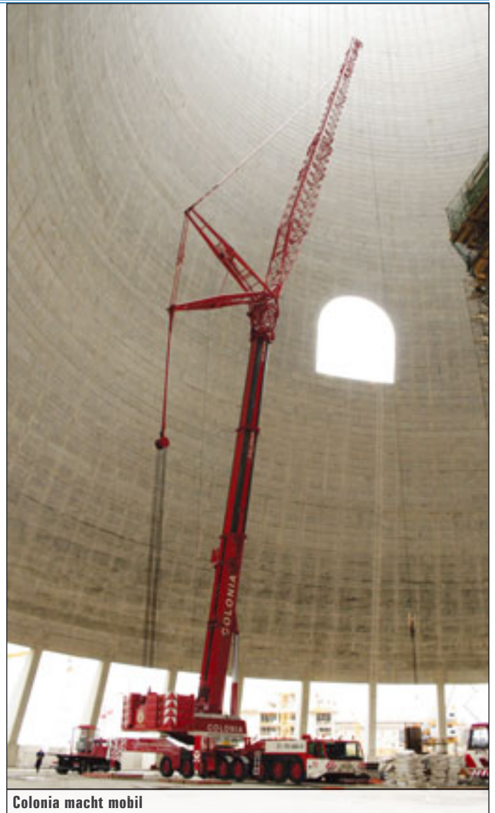
Segment von Segmüller: BKL mit Tandemhub
