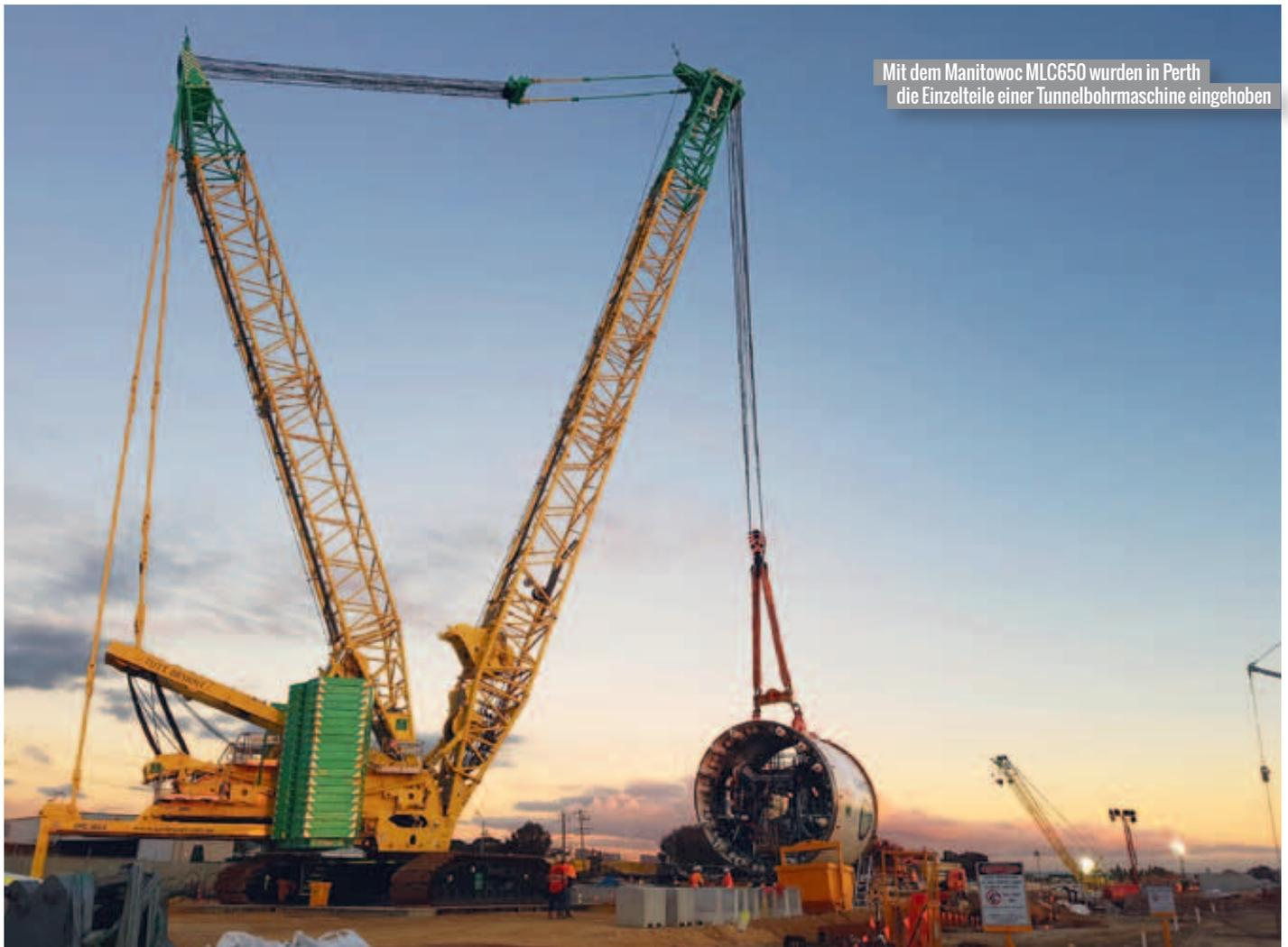
Mit dem Manitowoc MLC650 wurden in Perth die Einzelteile einer Tunnelbohrmaschine eingehoben
