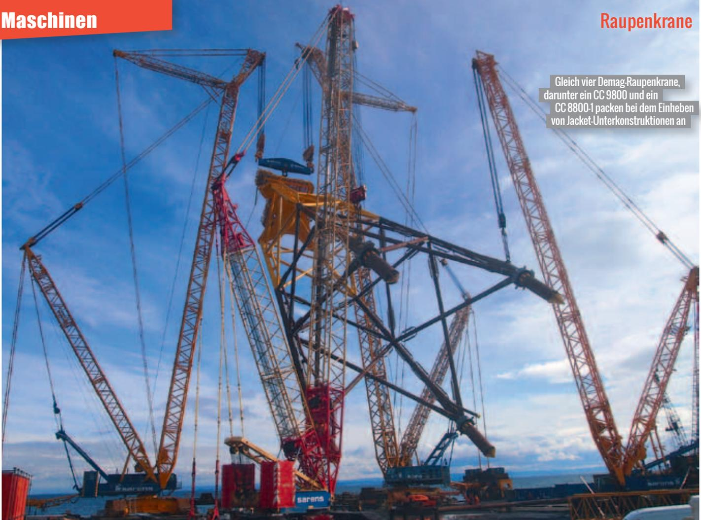
Gleich vier Demag-Raupenkrane, darunter ein CC 9800 und ein CC 8800-1 packen bei dem Einheben von Jacket-Unterkonstruktionen an
