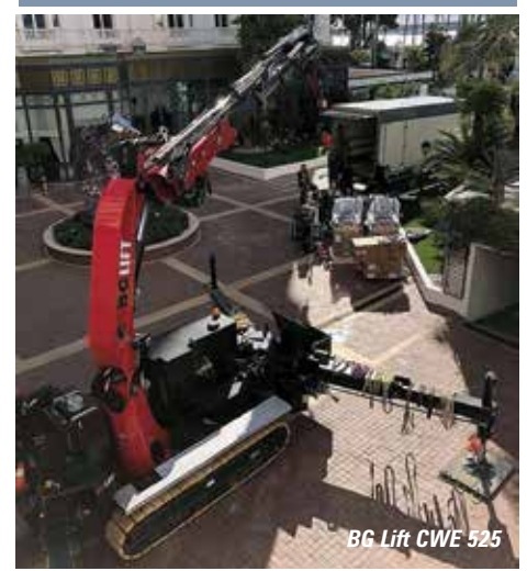
Sunward 10 tonne mini crawler crane
